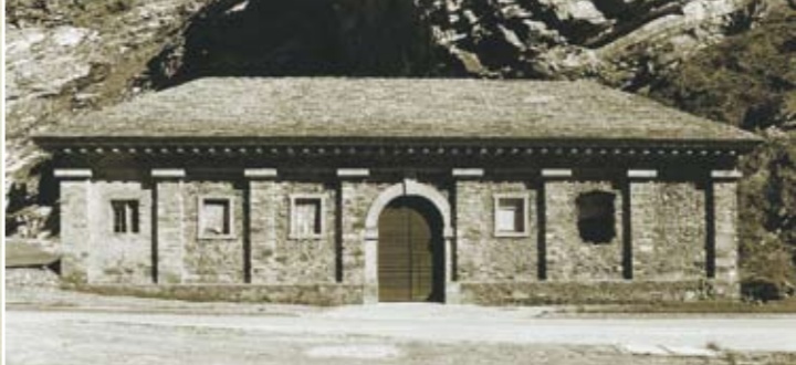
«Alte Kaserne» vor der Renovation im Jahre 2000
